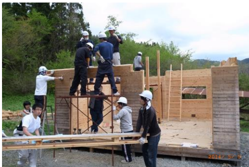
△泊区仮設公民館の解体
